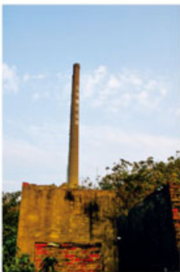
▲早期一支支高聳的磚廠煙囪羅列山麓
